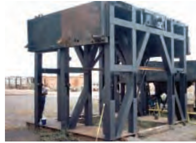
Sous-structure de tour de forage au chantier pour l'entretien
